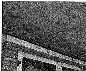
d. Procedere alla pulizia dei discendenti e delle gronde per evitare infiltrazioni d'acqua dalla copertura.
